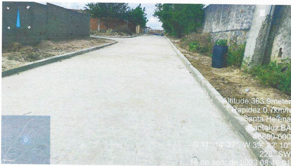
Execução de Pavimentação e meio-fio/Rua projetada 04 (trecho I)
