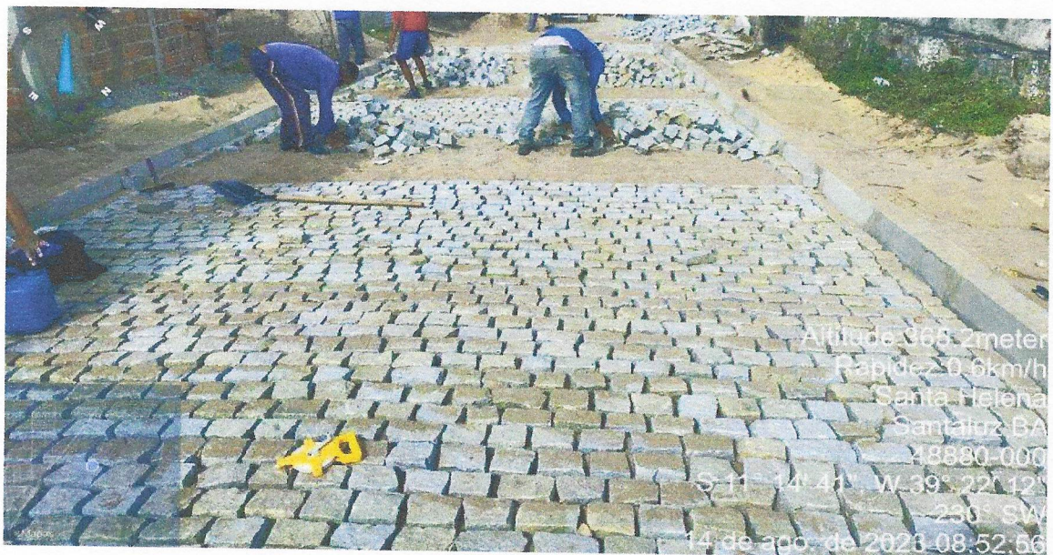
Execução de Pavimentação e meio-fio/Rua projetada 04 (trecho I)
