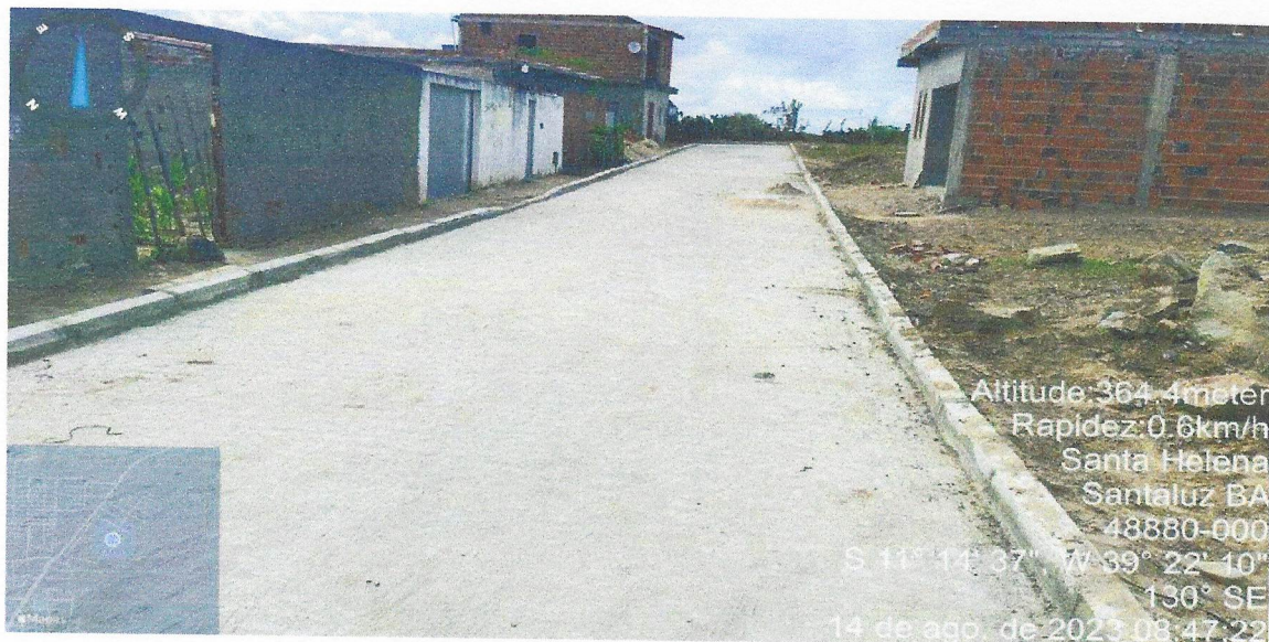
Execução de Pavimentação e meio-fio/Rua projetada 05
