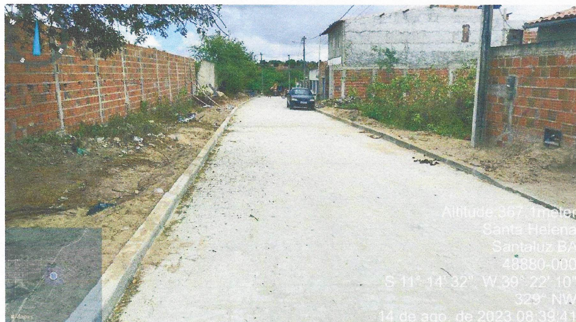
Execução de pavimentação e meio-fio/Rua projetada 12
