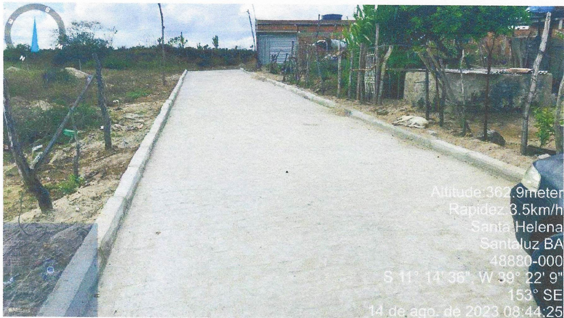
Execução de Pavimentação e meio-fio/Rua projetada 06
