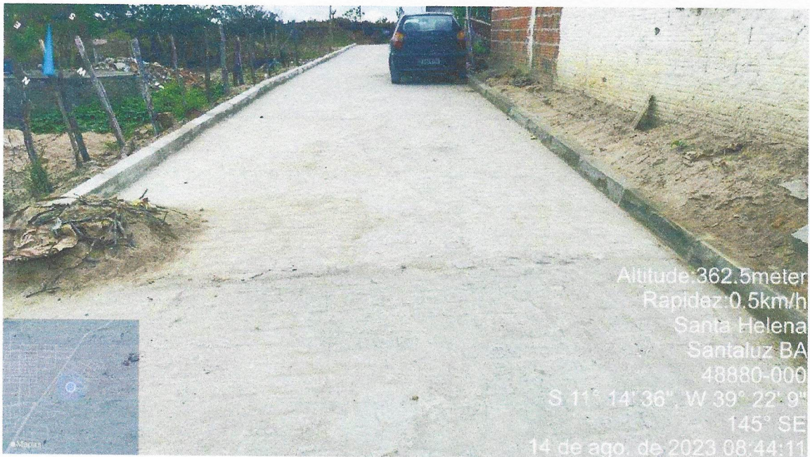
Execução de Pavimentação e meio-fio/Rua projetada 06
